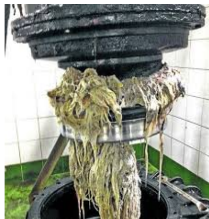
Atasco de toallitas en la Estación de Bombeo de A Goleta © Concello de Marín
