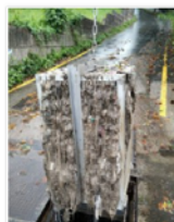
Atasco de toallitas en la Estación de Bombeo de A Goleta © Concello de Marín
